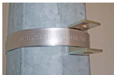
Fixation par feuillard 20 mm Secured with a 20 mm steel band
